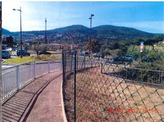
Passage du Riou Blanquet sous un giratoire
