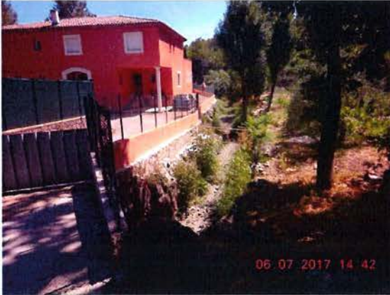
Vallon Saint Antoine à proximité d'une habitation
