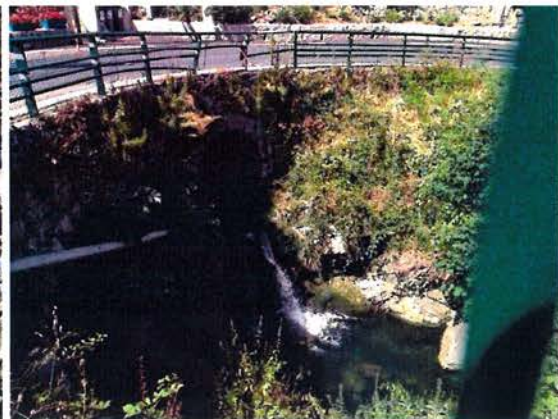
Pont suivi d'un seuil sur le Riou Blanquet
