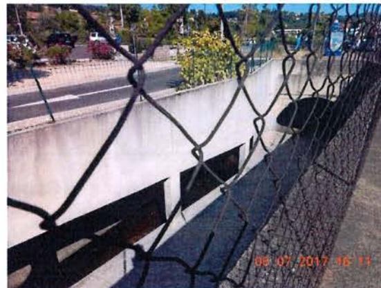
Ouvrage galerie sous le Riou Blanquet
